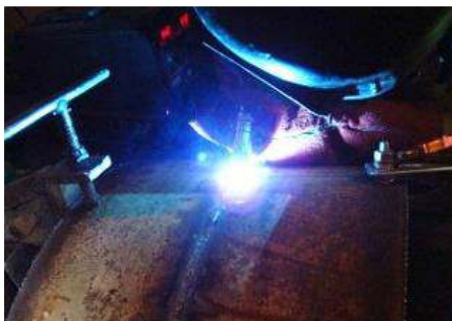
Figure 5. Root layer welding - X 42 Figura 5. Sudarea stratului de rădăcină - X 42
