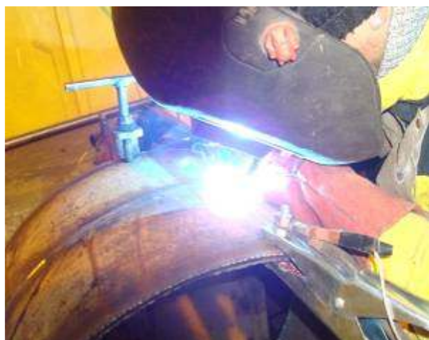
Figure 7. Root layer welding - X 52 Figura 7. Sudarea stratului de rădăcină – X 52
